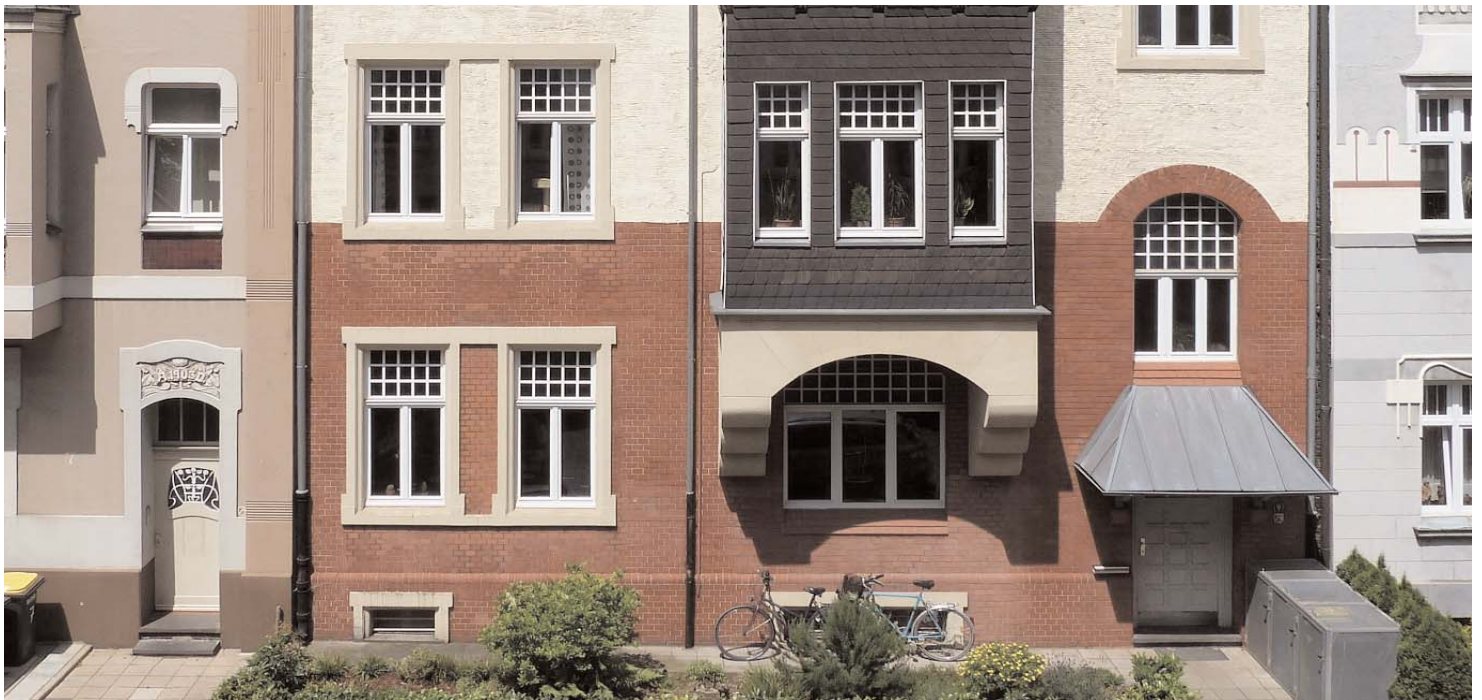
Aufwendige Altbau-Fassaden verbieten den Einsatz von Styropor-Dämmplatten, der sich auch nicht immer lohnt. In Bottrop arbeiten Forscher daran, das Energiesparen in Gebäuden mit billiger Technik zu erleichtern. Foto: Tom Jost
